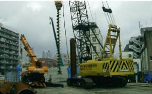
硬質地盤への鋼管矢板の圧入
