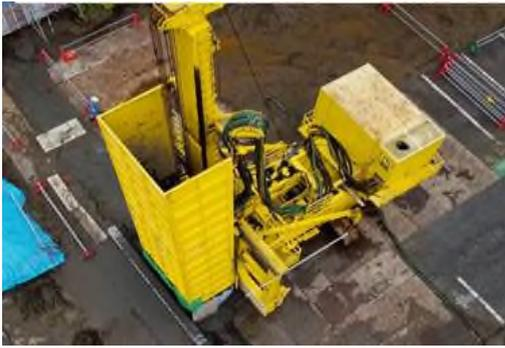
無排土施工が可能な耐震性遮水壁工法
