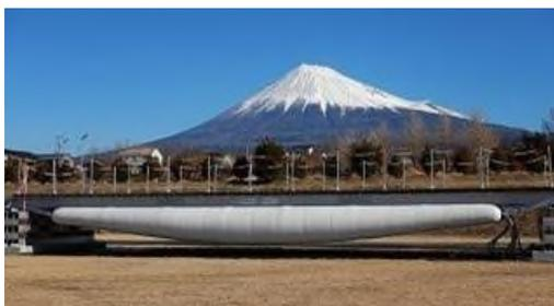
鋼製応急組立橋に比べ迅速に架設できる緊急仮設橋
